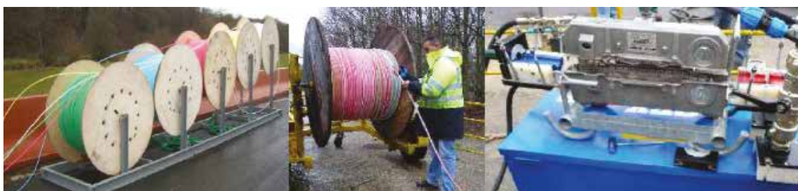
Figure 5.18 : pose de micro-tubes indépendants et micro-conduite
