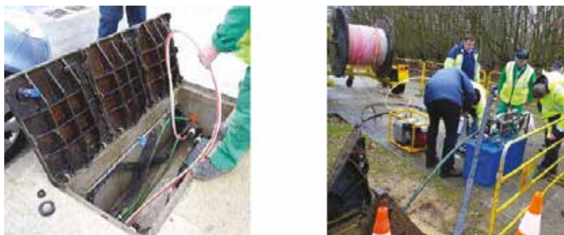
Figure 5.17 : pose de micro-tubes indépendants
