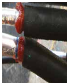
Figure 5.45 : entrée de câble par thermo rétractable
