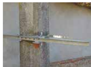
Figure 5.37 : mise en place de traverse
