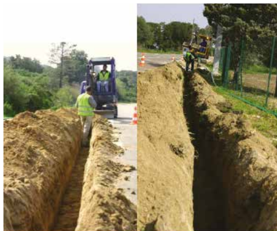
Figure 5.8 : pose de fourreau en tranchée standard
