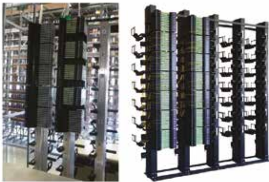
Figure 4.33 : répartiteurs sur fermes
