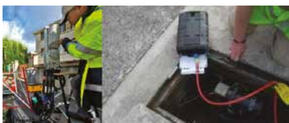
Figure 5.44 : installation d'un boîtier dans une chambre
