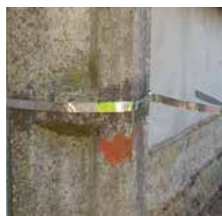
Figure 5.35 : mise en place du cerclage feuillard
