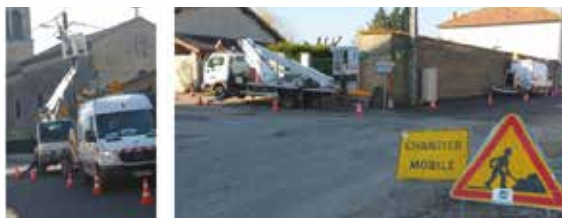
Figure 5.32 : mise en place du balisage
