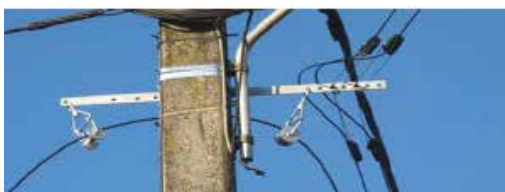
Figure 5.34 : passage dans les poulies
