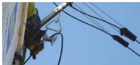
Figure 5.33 : mise en place des poulies provisoires
