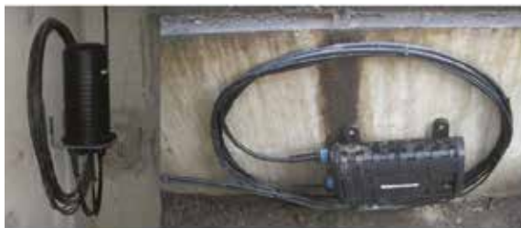
Figure 5.43 : positionnement d'un joint dans une chambre
