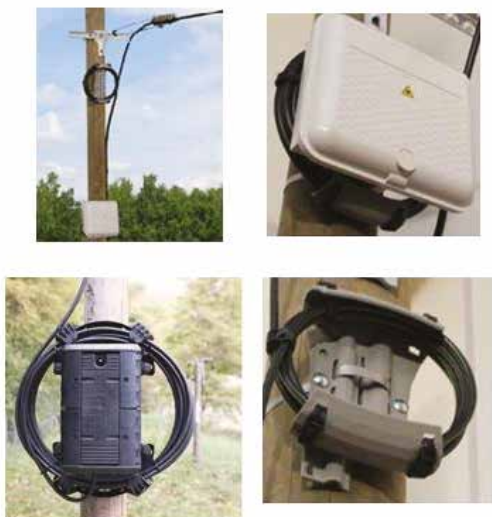
Figure 5.41 : dispositifs de lovage ajustable
