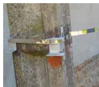
Figure 5.36 : mise en place d'équerre
