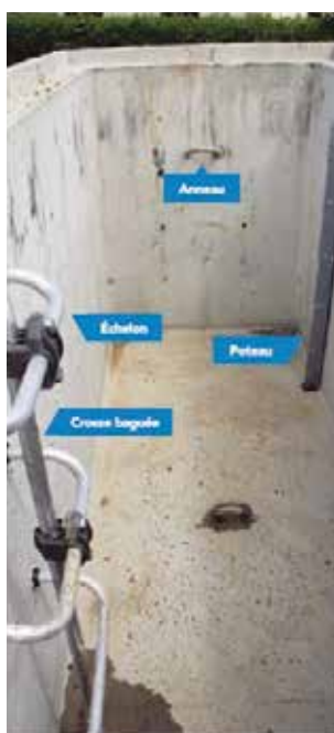
Figure 4.4 : chambre béton et accessoires
