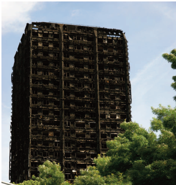
Grenfell Tower, London, nach der Brandkatastrophe vom 14. Juni 2017
