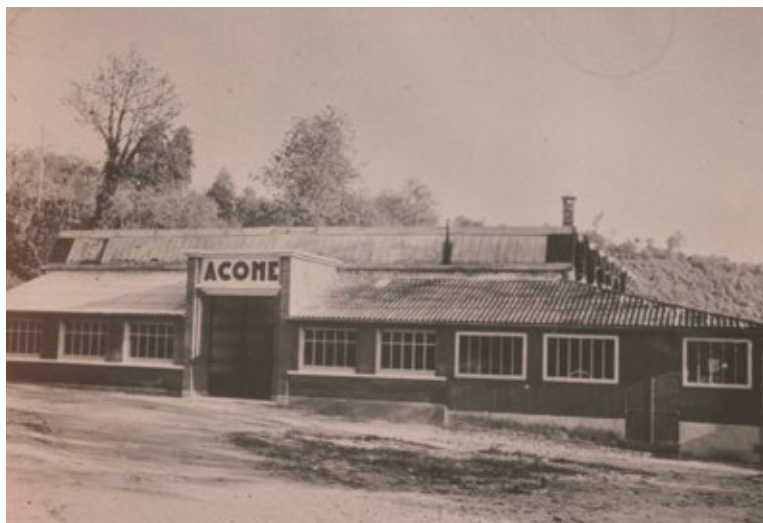
1 er site d'ACOME en Normandie (Usine des Vallées, Mortain) cédé à la collectivité en 2021.
